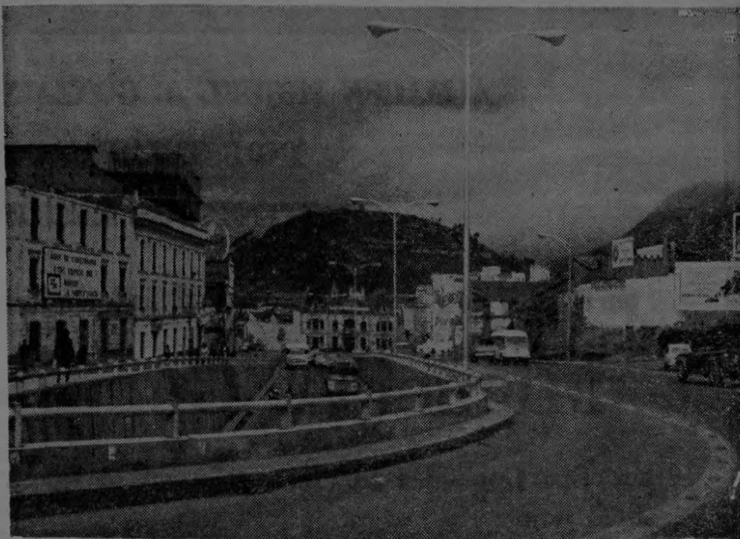
SAN BLAS SUR: Este paso a desnivel que se encuentra en la Parroquia de San Blas, en donde empieza la parte colonial de Quito, permite la fluidez del tránsito hacia varios rumbos evitando congestionamientos. Al fondo se ve el pintoresco Cerro del Panecillo. (Foto Gutiérrez).
